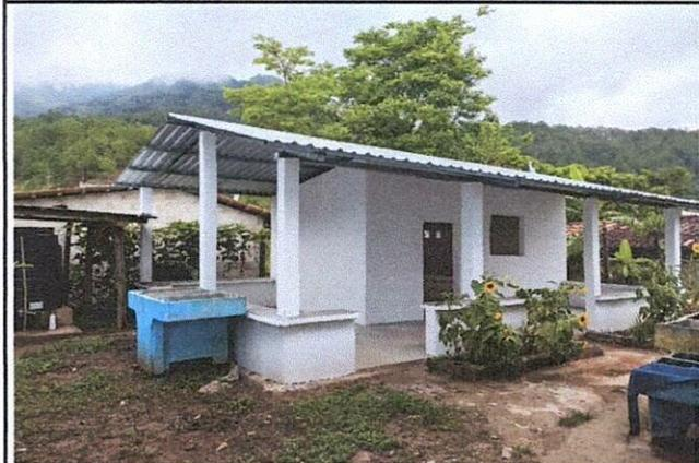
Foto 4: Finalización de reparación y remodelación de techo, cocina y piso.
